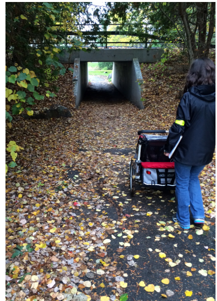
Figure 4.3: le passage souterrain Varley du sentier Gow n'est pas d'une hauteur suffisante pour être pratique.
