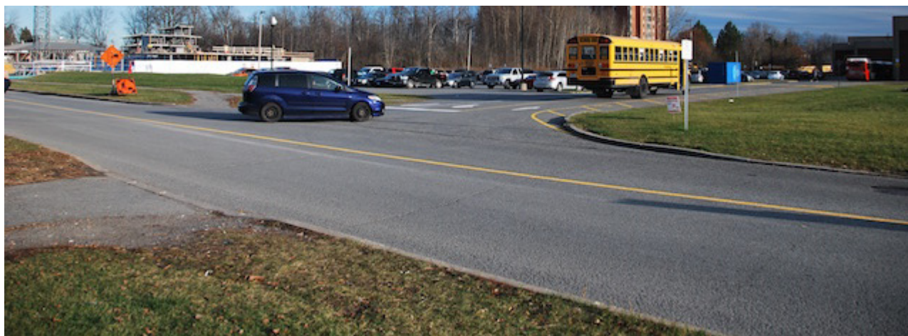
Figure 4.6 : le taux élevé de la circulation automobile dans la zone écolière Earl of March nécessite l'installation de passages piétonniers et/ou un contrôle du trafic.
