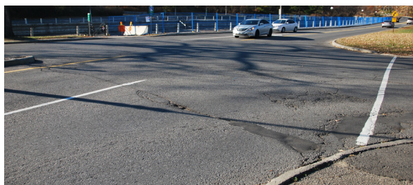
Figure 4.10 : il manque des passages pour piétons pour lier les sentiers de la CCN au réseau piétonnier municipal et aider aux utilisateurs à traverser en sécurité.
