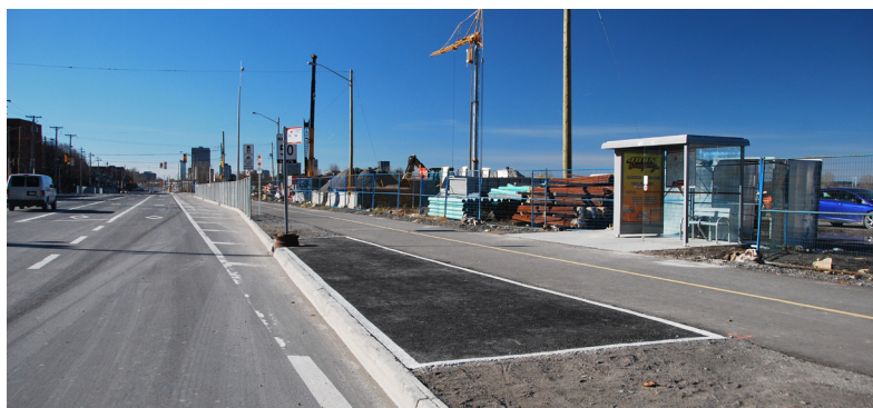
Figure 4.13 : la récente réfection du sentier polyvalent et des arrêts d'autobus de la rue Scott ont été vastement améliorés depuis les évaluations.
